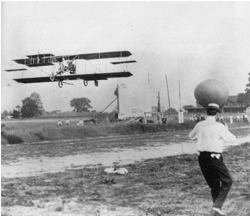
6. ábra Curtiss teszteli a „Golden Flyer”-t; megfigyelhető a két szárny között elhelyezett csűrőkormány
